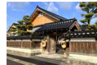
国登録有形文化財「室木家」移築工事・完了
